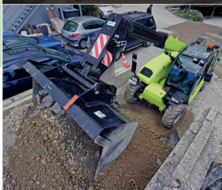
Materialhandling mit Schaufel im Werkhof, auf der Baustelle übernehmen das die Bagger der Garten Design AG
