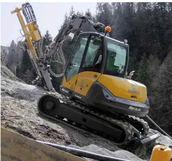
Die Universalmaschine Mecalac 8MCR bei der Hangsicherung im Sitter-Tobel.
