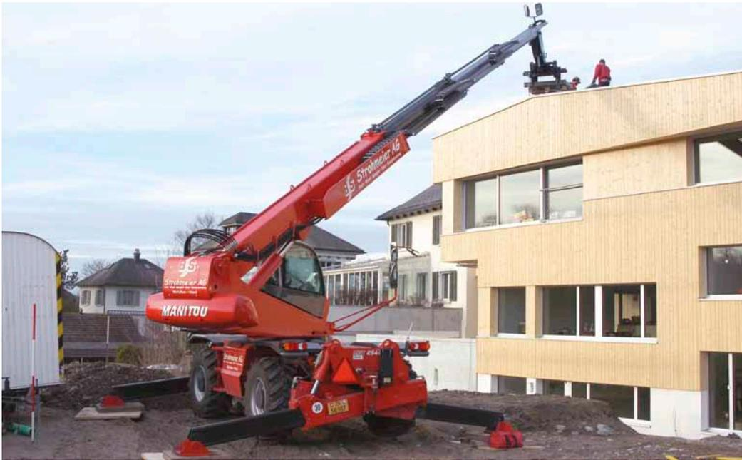
Ausgerüstet mit Palettengabel platziert der MRT 2540 über Baugruben hinweg Teile für die Solaranlage auf dem Dach.
