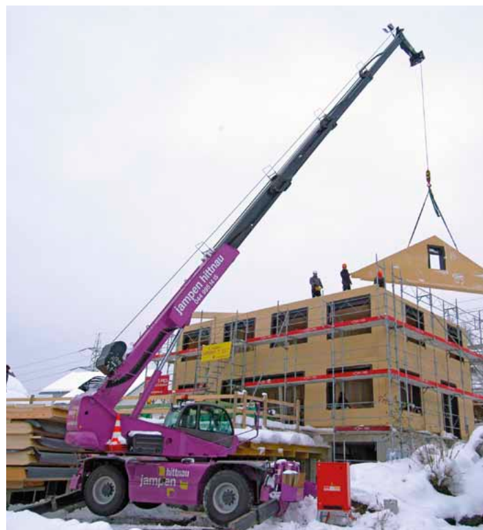
Montageteil des Dachstuhls – eine Leichtigkeit für den Manitou MRT 3050.
