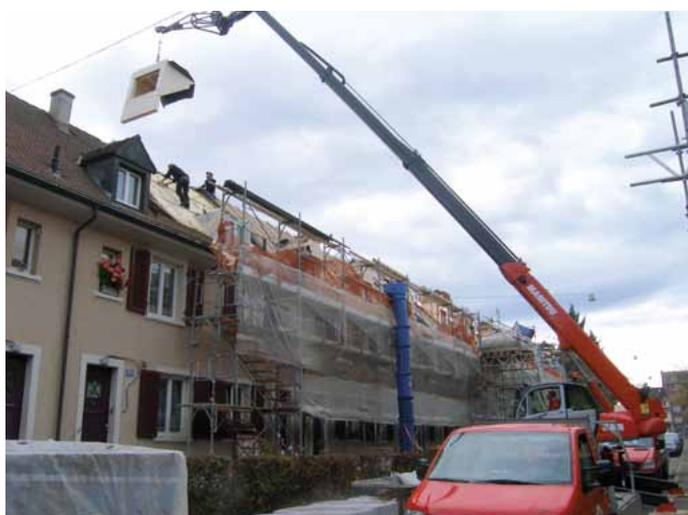
Hoch hinaus dank der Seilwinde mit Gitterkran. Mit dieser Vorrichtung kann der Manitou im Holzbau bei Gebäudehöhen von über 20 Metern eingesetzt werden.
