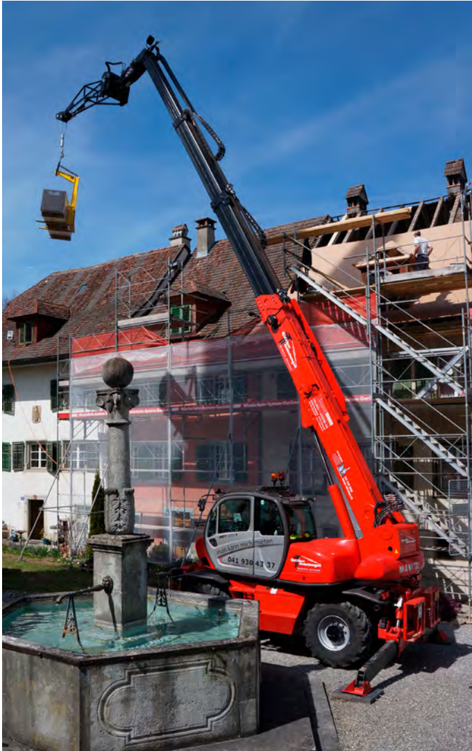
Mit Auslegerwinde kein Ein-/Ausfahren des Masts
